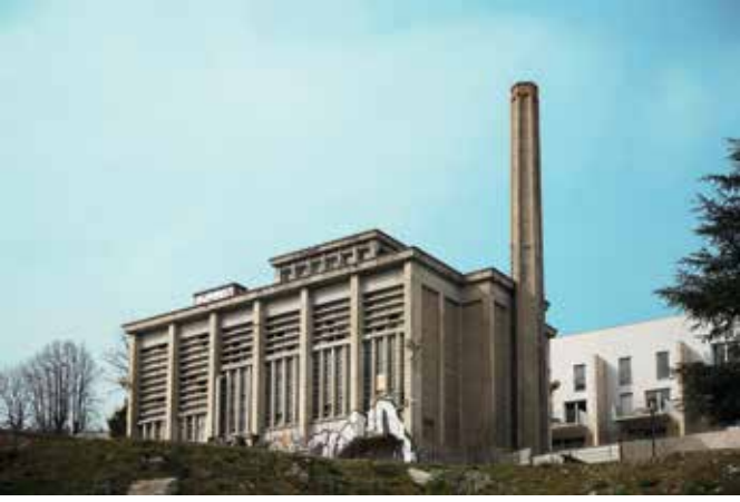
LA CHAUFFERIE DE L'ANTIOUILLE © Stéphane Rambaud
